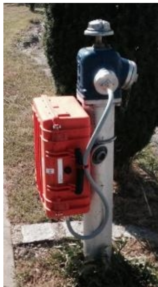
Abbildung 102: Druckmessung mit einem Messkoffer an einem Hydranten
