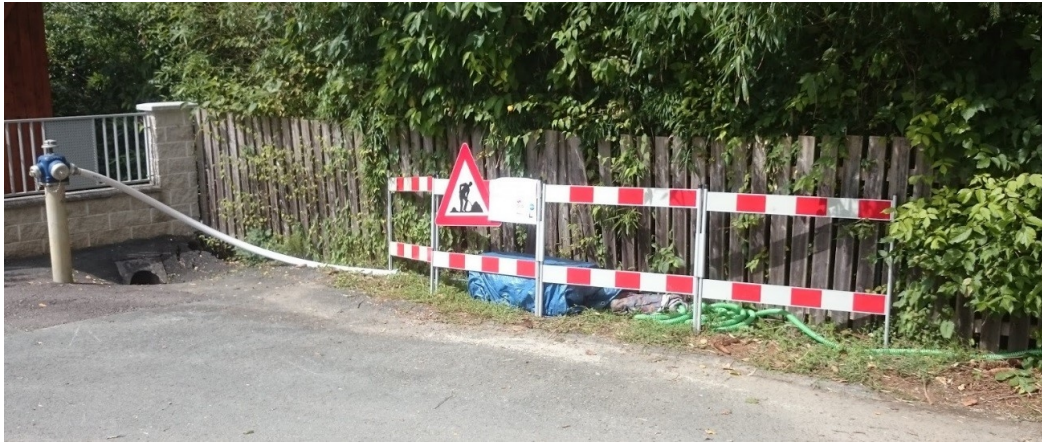
Abbildung 64: Simulierter Rohrbruch an einem Hydranten und Absicherung gegenüber öffentlichem Verkehr
