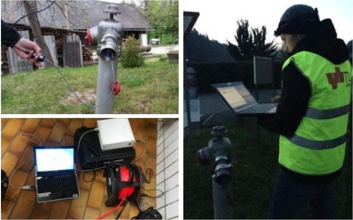
Abbildung 67: Auslesen der Sensoren im Behälter und am Hydranten
